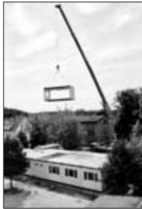
Containeraufbau an der Grundschule
