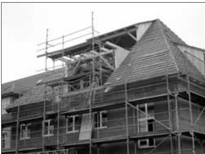
Baumaßnahme Schillerstraße 1 a - Kinder- und Familienzentrum
