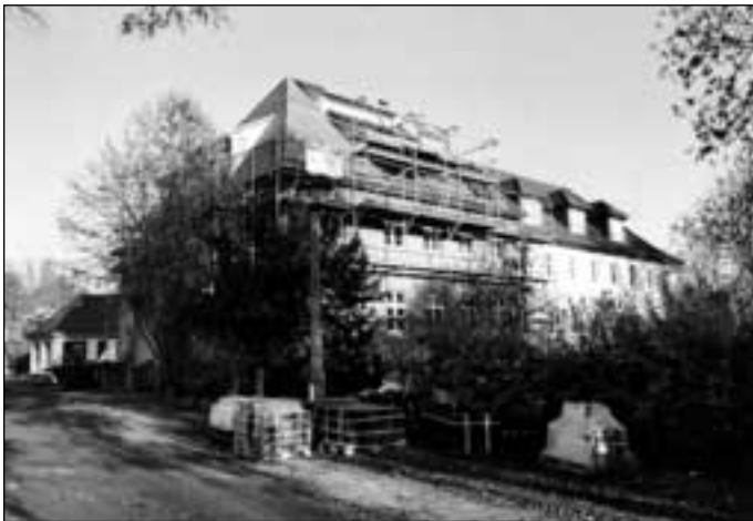
Das Baugeschehen an der Schule Berg im Oktober 2008
